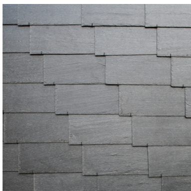
LEIEN Gevel en dak
